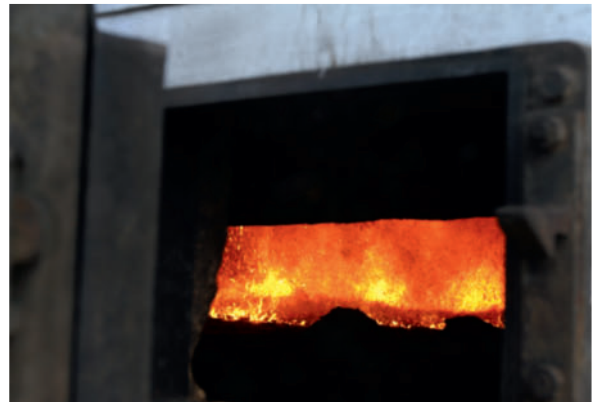
Verfeuerung des Brennstoffs im Hochdruckbrennstoffkessel
