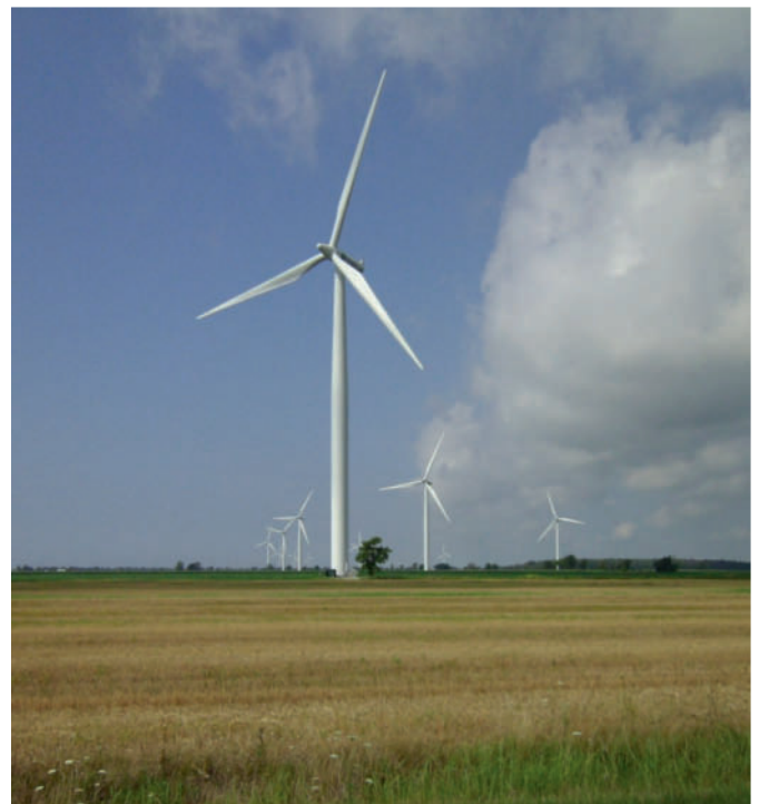
Onshore-Windpark mit Sany-Technologie
