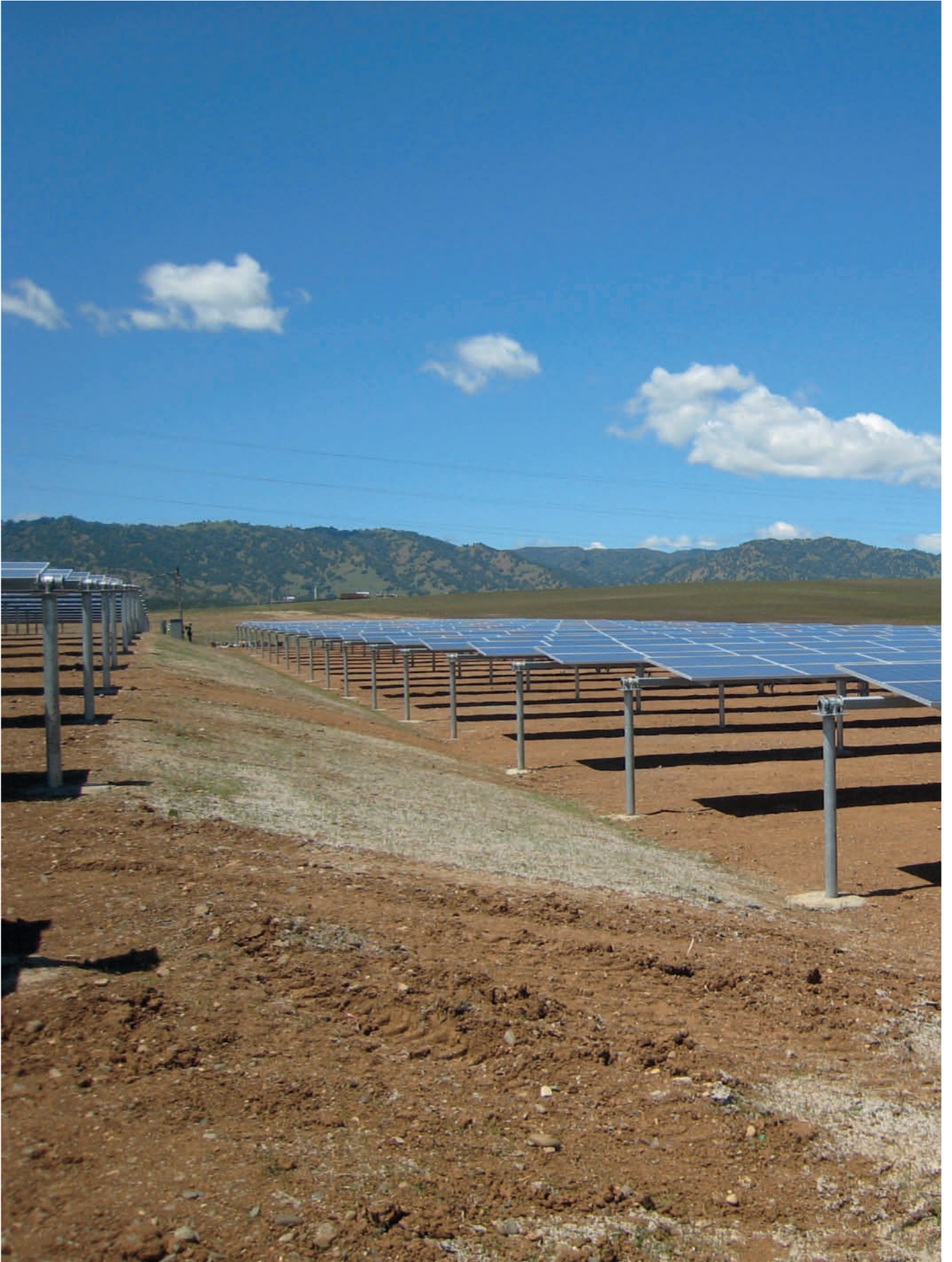
Solarpark mit einachsiger Horizontalführung von Ray Tracker in der Stadt Winters im US-Bundesstaat Kalifornien
