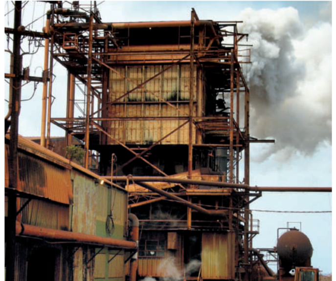
Dampfturbinenkraftwerk auf Hawaii
