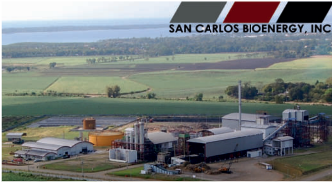
San Carlos Bioenergy – die erste Bioethanoldestilliererei mit KWK-Kraftwerk auf Zuckerrohrbasis in Asien
