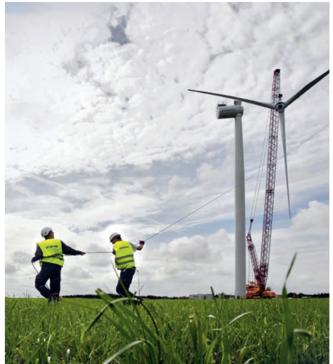
Erichtung eines Windrads durch Sany-Mitarbeiter
